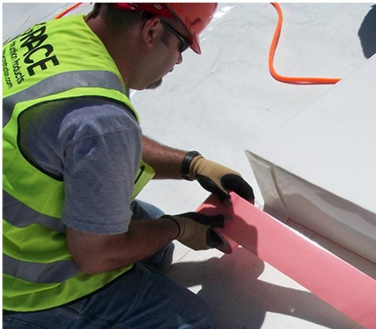
La construction de l'aéroport en Irlande exigeait l'étanchéité au-dessous du niveau du sol, en particulier pour les murs, ainsi que les poteaux en béton armé. Située sur un site en pente, les ingénieurs ont conçu un drainage au-dessous du niveau du sol sous la dalle, car ce n'était pas un sous-sol monolithique. Par conséquent, une membrane adaptée pour une application dans des zones humides était également requise.
