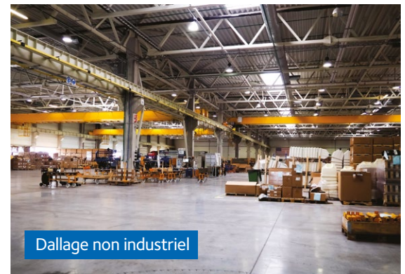
2,0 kg/m 3 , jusqu'à 1 tonne/m 2 sur 130 mm
